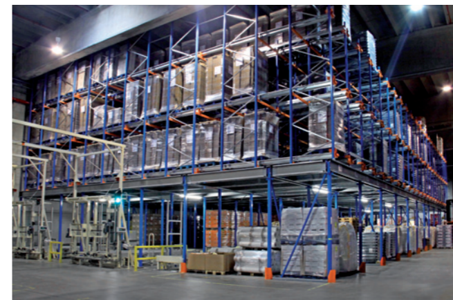
Dankzij de oplossing van Stow genereerde Poco Loco de broodnodige extra opslagruimte.
