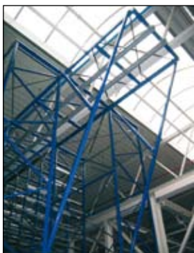
Auskragung für obere Führungsschiene
